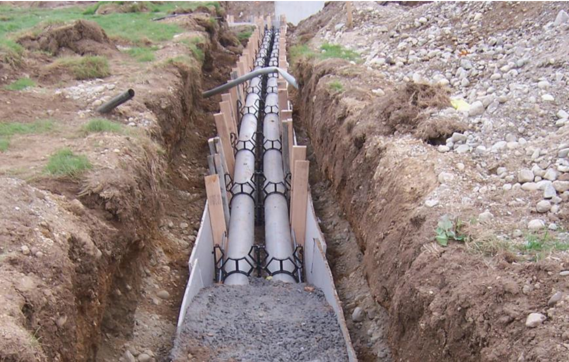
Picture of Conduit Installation Before Concrete Pour
